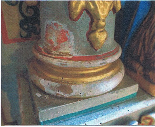
Fot. 13. Fragment kolumnienki z ołtarza głównego w kościele filialnym pw. św. Jana Chrzciciela w Mysławie. Widoczna pierwotna kolorystyka - czerwona marmoryzacja. Wrzesień, 2020 r.
