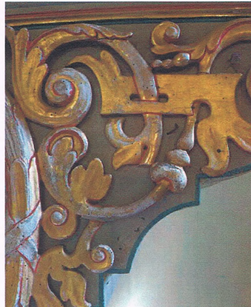
Fot. 5. Prawa strona predelli. Stan złożonej snycerki. Widoczne drobne ubytki zapraw oraz złoceń.
